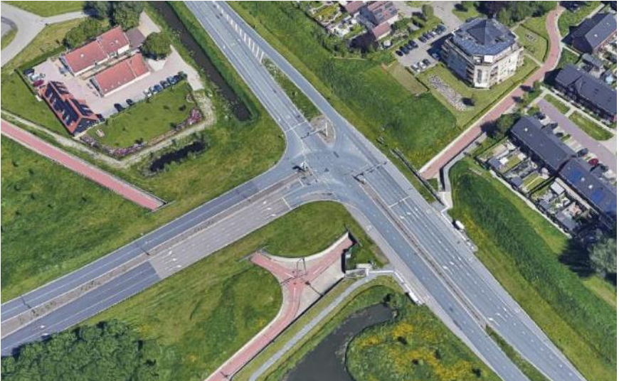
Figuur 18 Voorbeeld fietsonderdoorgang (Houten)
