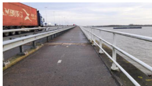
Figuur 50 Reling/leuning Moerdijkbrug
