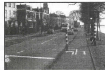
aanliggend fietspad tweezijdig bereden
