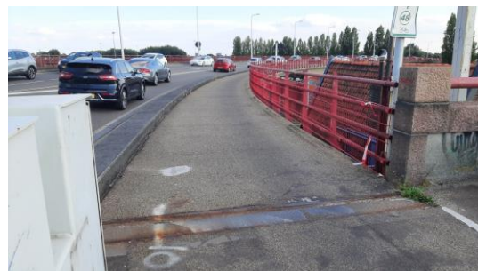
Zuidzijde brug Dordtse kant
