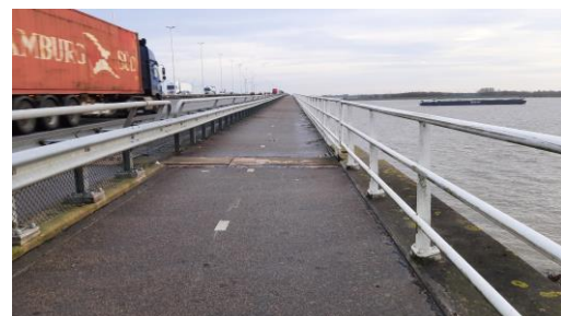
Figuur 50 Leuning Moerdijkbrug
